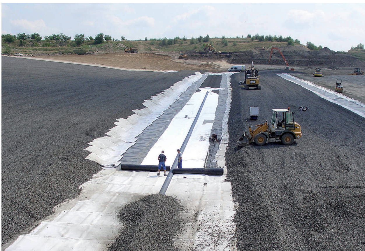
Abb. 3.2.1: Bau der Bauschuttdeponie Deetz (Quelle MEAB 2009)
