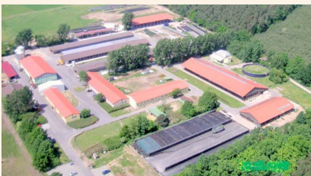
Fig. 3: LVAT site in Groß Kreutz
