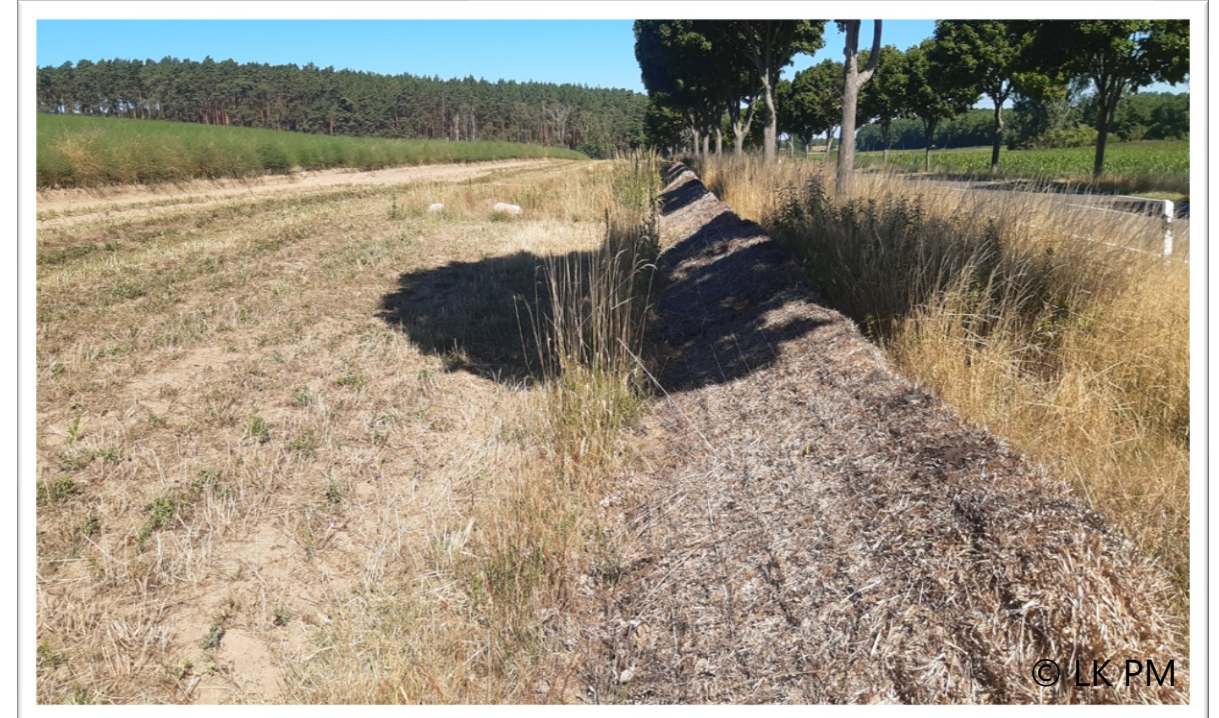
Strohballen zur Verhinderung der Befruchtung der Landesstraße mit Boden
