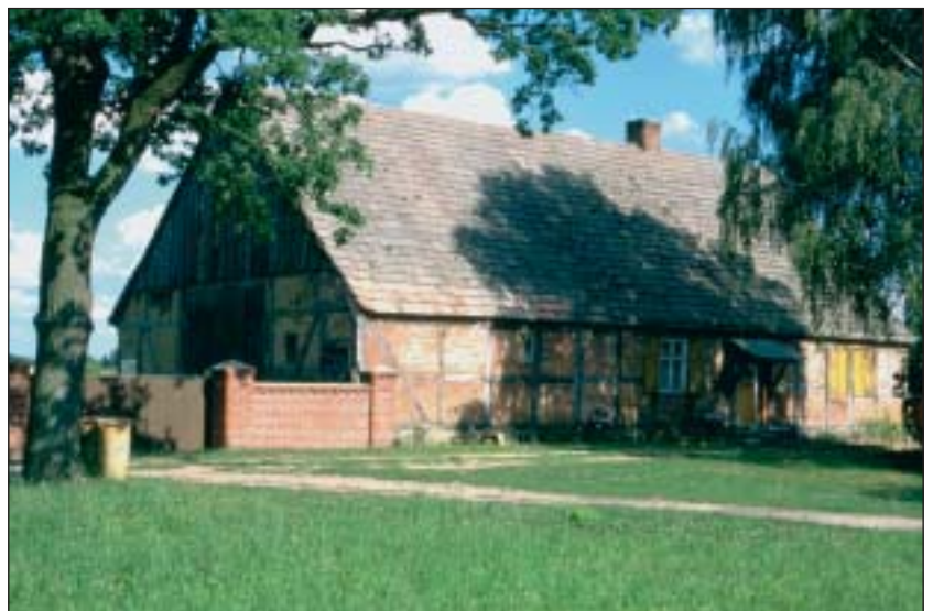
Hof unter einem Dach , Wohnstallhaus (Holländerhaus) aus friderizianischer Zeit, um 1782 (Neuwerder, Havelland)
