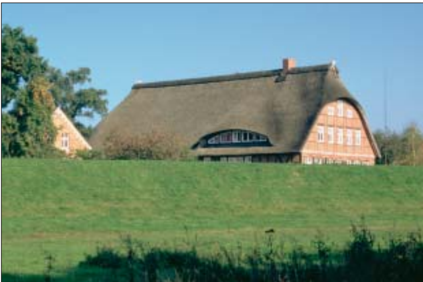
Niederdeutsches Hallenhaus hinter dem Elbdeich, Ziegel-Fachwerk, Rohrdeckung; spätes, umgebautes Beispiel, datiert 1873; saniert, neue breite Gaube; Ansicht Wohnteil (Besandten, Prignitz)
