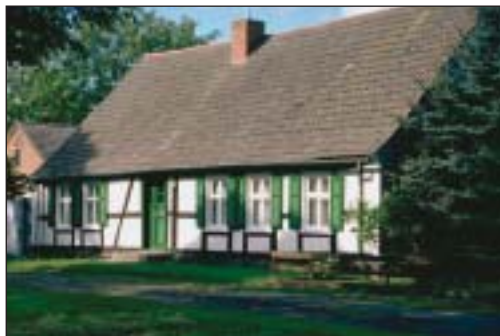
Quer geteiltes Wohnhaus als Fachwerkbau, vmtl. mit ehemals schwarzer Küche (ergibt sich aus der Lage des Schornsteins), Kolonistenhaus um 1800 (Neubarnim, Märkisch-Oderland)
