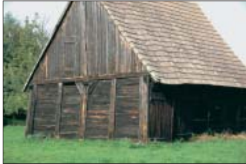
Kleine Feldscheune, Bohlen-Fachwerk, Giebel verbreitert, um 1800 (Gruhno, Elbe-Elster)
