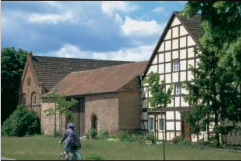
Vierseithof mit Torhaus als geschlossene Hofanlage; zweigeschossiges Fachwerk- Mittelfurhaus, um 1800, Nebengebäude später (Lühsdorf, Potsdam-Mittelmark)
