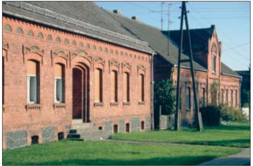
Ziegelsichtmauerwerk aus der Zeit des Jugendstil, äußerst selten und hervorragend erhalten; hinten mit Zwerchgiebel; Segmentbogenfenster, Feldsteinsockel, um 1910 (Krampfer, Prignitz)
