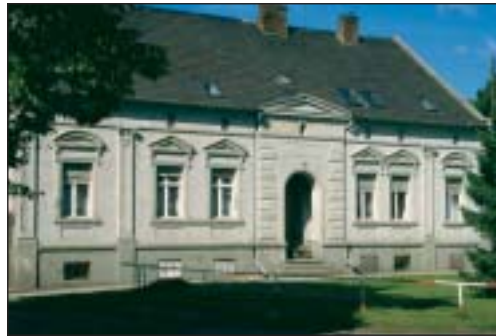
Quer geteiltes Wohnhaus der Gründerzeit, Massivbau mit Stuckfassade, übergiebelter Mittelrisalit, Drempe mit kleinen Drempefenstern, bis auf Dachdeckung vollständiger Originalzustand, um 1900 (Staffelde, Oberhavel)
