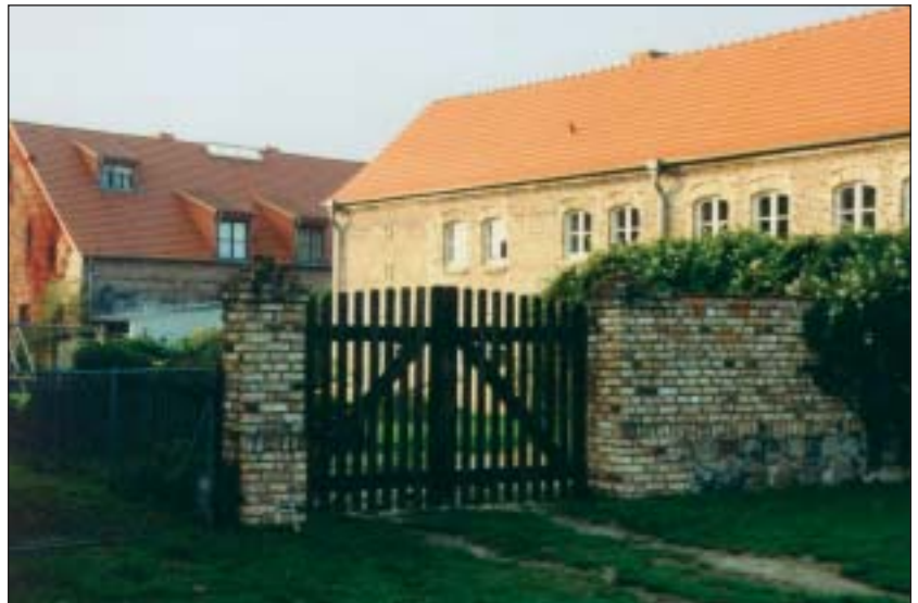
Stall und Scheune zu Wohnraum umgenutzt (Wildenbruch, Potsdam-Mittelmark)
