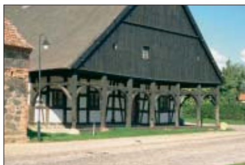
Giebellaubenhaus, Mittelflurhaus mit Giebellaube, Fachwerk, Giebel verbrettert, um 1720, rekonstruiert 1991-97 (Pillgram, Oder-Spree)
