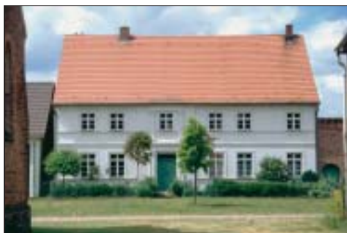
Quer geteiltes Wohnhaus der Gründerzeit, Massivbau mit Stuckfassade, zweigeschossig, Eingangsbereich mit Risalit, neue Biber-Kronendeckung, perfekt saniert, um 1880 (Lühnsdorf, Potsdam-Mittelmark)
