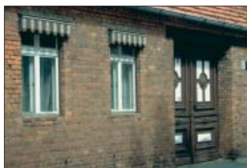
Alte Vorsatzrolläden mit verzierten Rolladenkästen aus der Zeit etwa um 1900, ein seltenes Beispiel in guter Erhaltung. Große schwere Haustür der Gründerzeit, Fenster nicht mehr original (Baruth, Teltow-Fläming)
