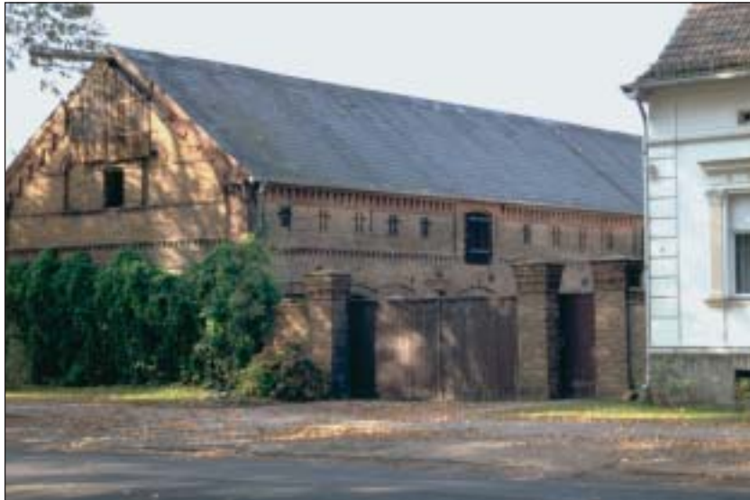
Großer Stall-Speicherbau, Ziegel-Sichtmauerwerk mit Ladeluke am Giebel, massive Torpfeiler, Vierseithof um 1900 (Groß Schulzendorf, Teltow- Fläming)
