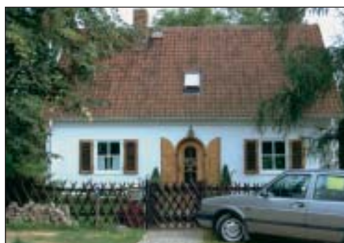
Wohnhaus im Heimatstil, Rundbogen-Tür mit Klapppläden, ursprüngliche Hohlpfannendeckung, um 1940; der Scherengitterzaun passt jedoch besser in den Außenbereich (Neu Fahrland, Potsdam-Mittelmark)
