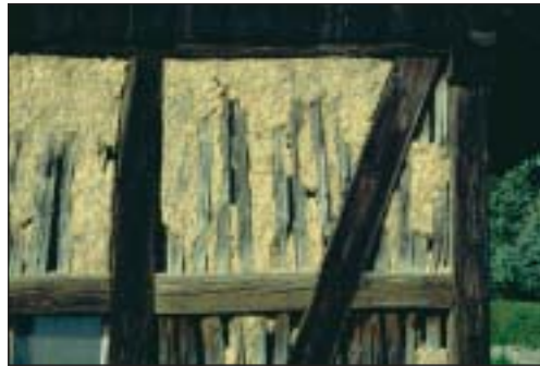
Lehmstakenfachwerk, Holzstaken mit Strohlehm, Detail einer im Verfall befindlichen Scheune, um 1800 (Schönwalde, Elbe-Elster)
