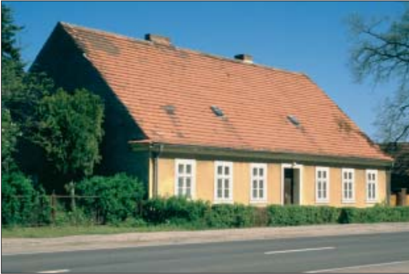
Quer geteiltes Wohnhaus als Massivbau, mitteldeutscher Haustyp in der Tradition der preußischen Landbauschule, Pfarrhaus von 1828 (Rottstock, Potsdam-Mittelmark). Bauten dieser Art galten als Vorbild für den Heimatstil und wurden als Musterbauten für das ländliche Bauschaffen der Mark Brandenburg propagiert.
