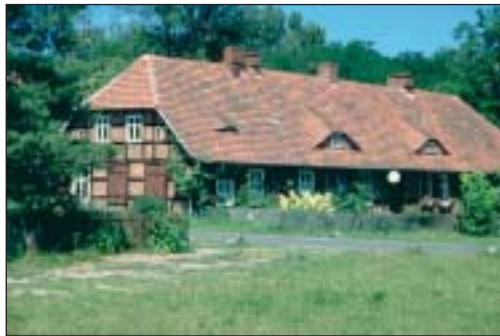
Reihenhaus für Arbeiter eines Manufakturdorfes, 1829, Ziegel-Fachwerk mit Krüppelwalmdach (Glashütte, Teltow-Fläming)
