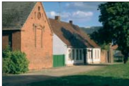
Offener Vierseithof, traufständiges Wohnhaus um 1820, Scheune vorn datiert 1897 (Neuwerder, Havelland)
