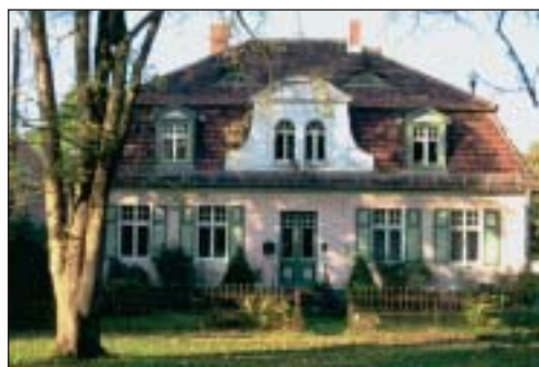
Wohnhaus im Landhausstil mit Mansard-Walmdach und Zwerchgiebel, vollständig in zeittypischer Ausstattung, um 1910-1920 (Sputendorf, Potsdam-Mittelmark)
