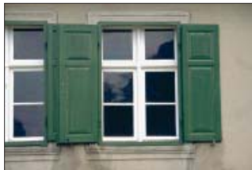
Alte Kreuzstockfenster in klassizistischer Teilung, je Unterflügel eine Sprosse, formal angegliche Füllungs-Klappen mit Teilung auf Höhe der Fensterteilung, um 1860 (Altranft, Märkisch-Oderland)
