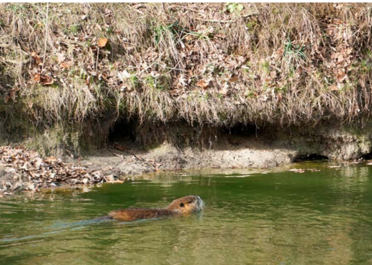
Schwimmende Nutria vor Zugängen zum Bau
