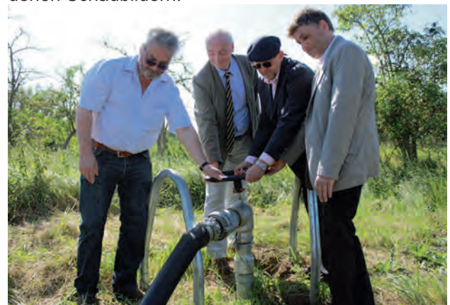
Abb. 5.6: Inbetriebnahme Pilotfläche August 2012
