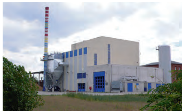
Abb. 5.10: Ansicht des Biomasse-Heizkraftwerkes Hennigsdorf
