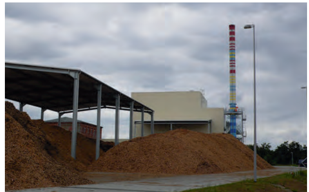
Abb. 5.11: Gut gefülltes Brennstofflager des BioHKW Hennigsdorf
