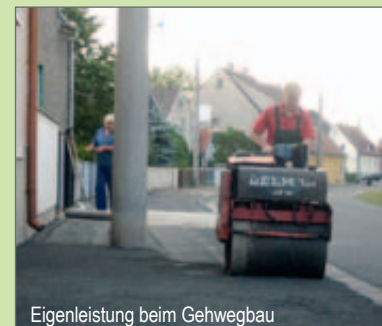
Eigenleistung beim Gehwegbau
