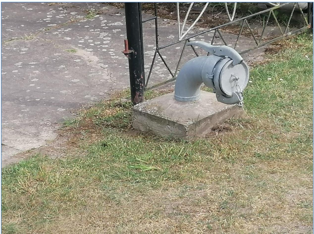
Abbildung 5: Absaugvorrichtung zur Entleerung einer abflusslosen Sammelgrube
