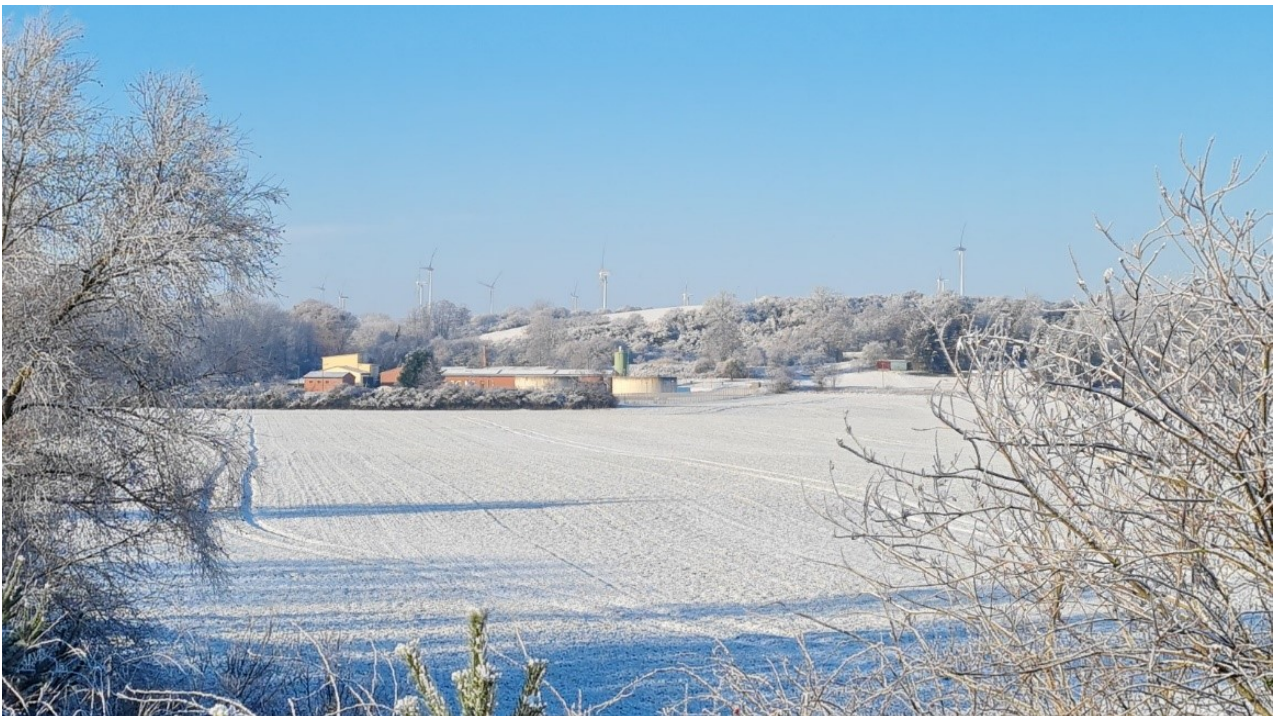
Abbildung 12: Blick auf die Kläranlage Seelow im Winter
