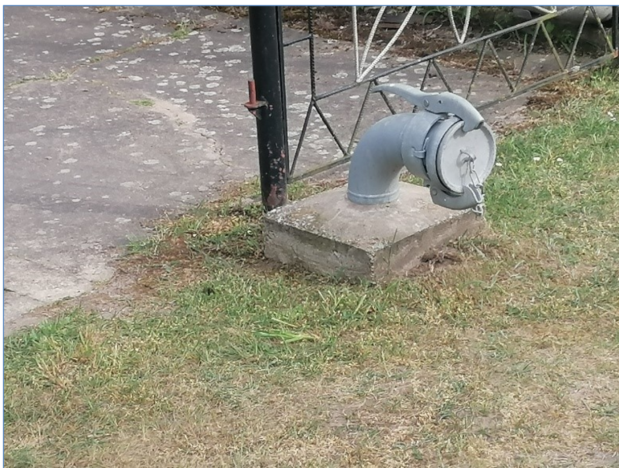
Abbildung 5: Absaugvorrichtung zur Entleerung einer abflusslosen Sammelgrube
