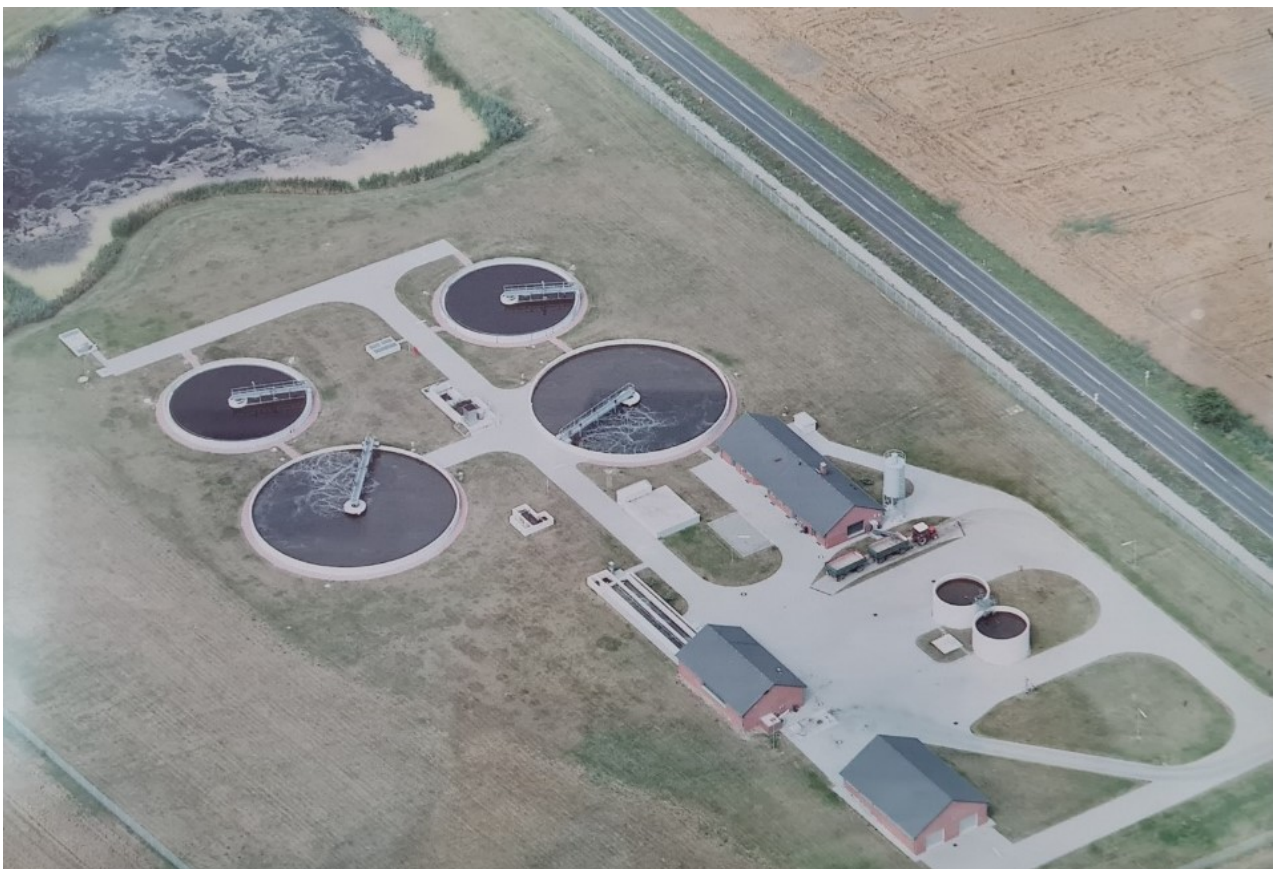
Abbildung 6: Blick auf die Kläranlage Manschnow von oben
