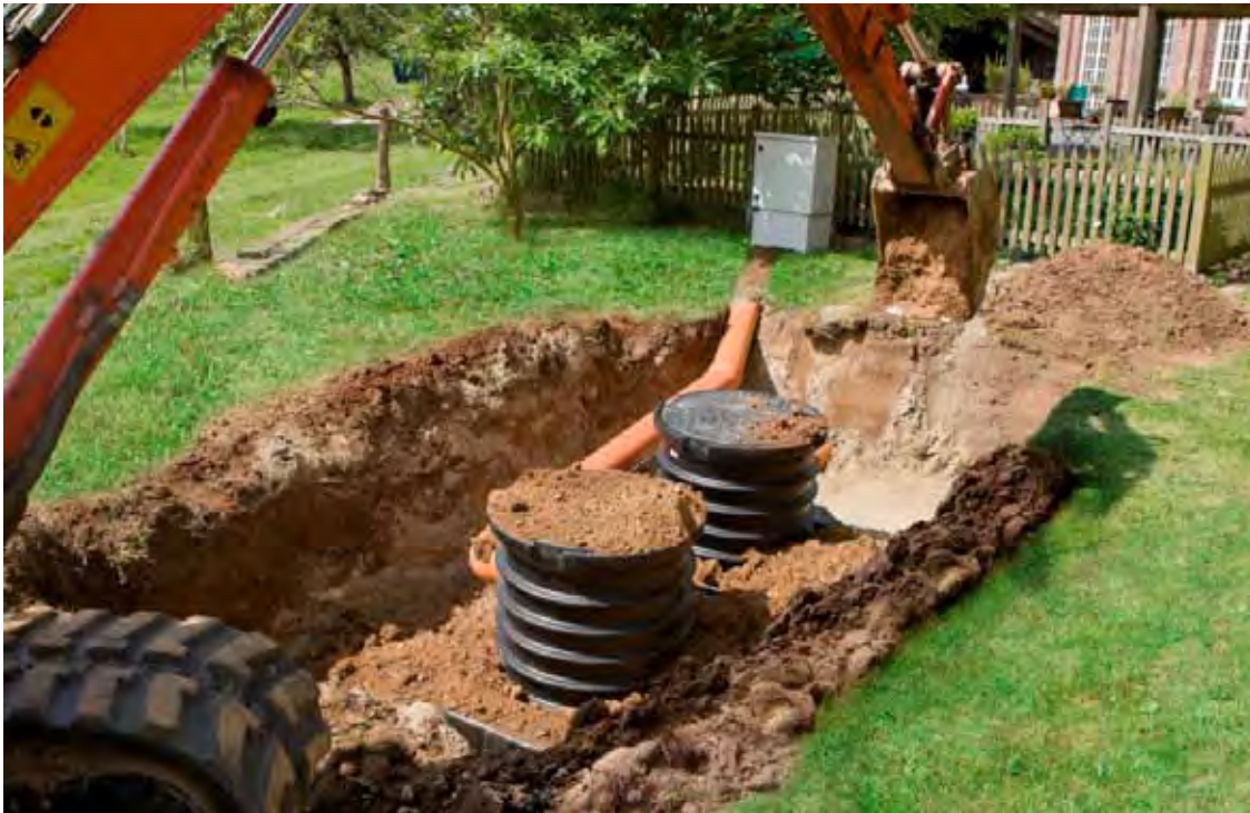
Abb. 10: Einbau einer vollbiologischen Kleinkläranlage
