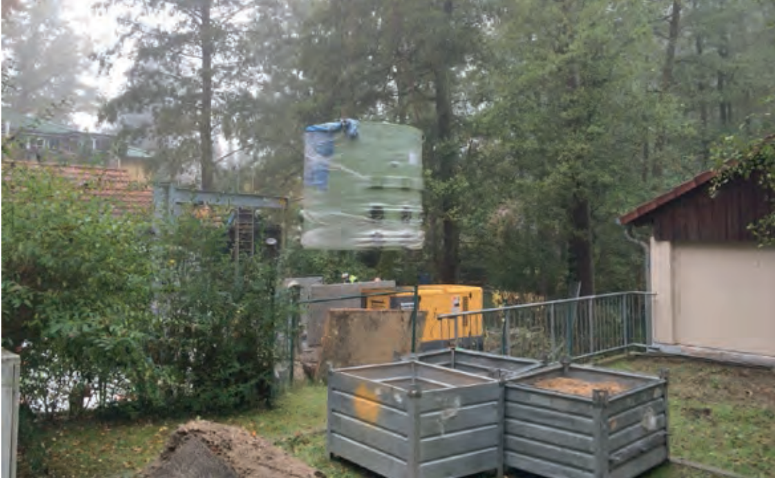
Abb. 13: Einrichtung eines neuen Sammelbehälters der feststofffreien Förderanlage im Zuge der Sanierung des Abwasserpumpwerks in Glienicke/Nordbahn
