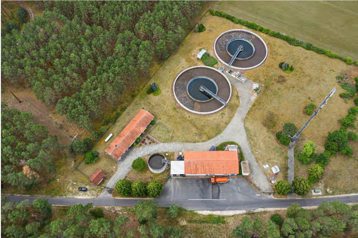
Abbildung 13: Luftbild der Kläranlage Alt Schadow (MAWV)
