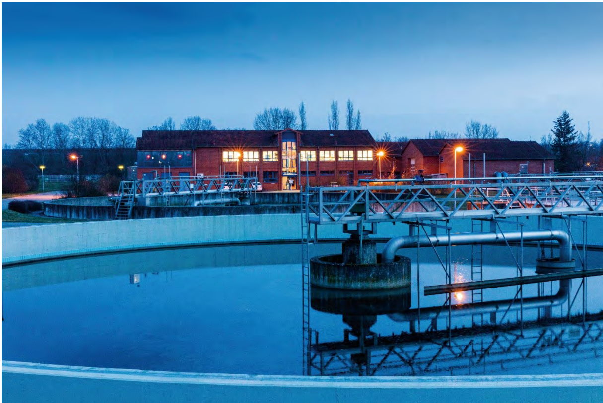
Abbildung 20: Kläranlage Frankfurt (Oder) (FWA mbH)
