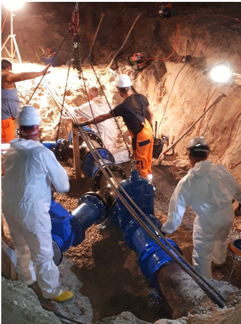
Abbildung 6: Sanierungsmaßnahmen an einer Abwasserdruckleitung - Nachtbaustelle (ZV Kremen)
