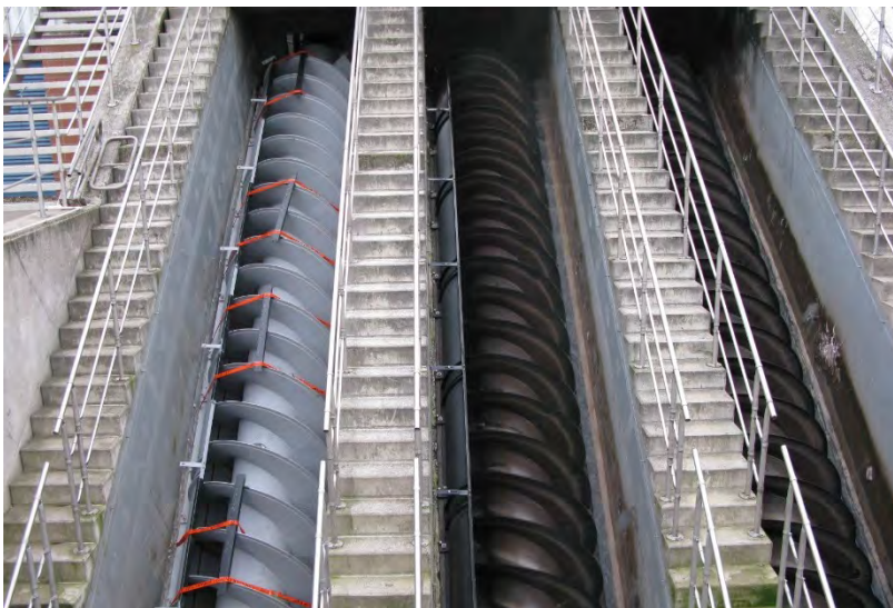
Abbildung 12: Einbau einer neuen Schneckenpumpe (FWA mbH)
