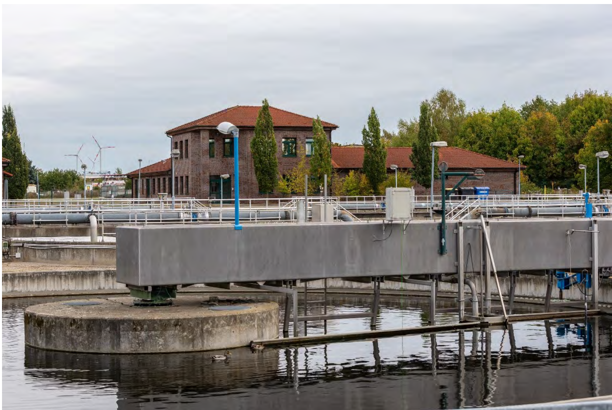
Abbildung 3: Kläranlage Prenzlau (Stadtwerke Prenzlau)
