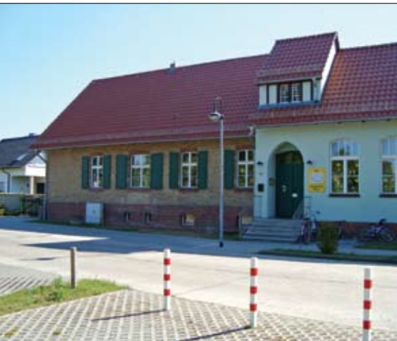
Abbildung 24: Sanierter Kindergarten; Netzen
