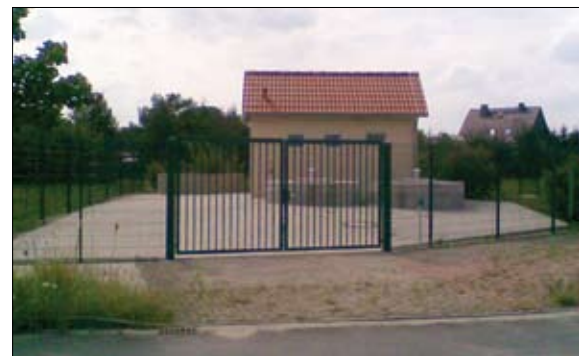
Abbildung 28: Pumpstation einer Vakuumleitung in Kroppen; Amt Ortrand
