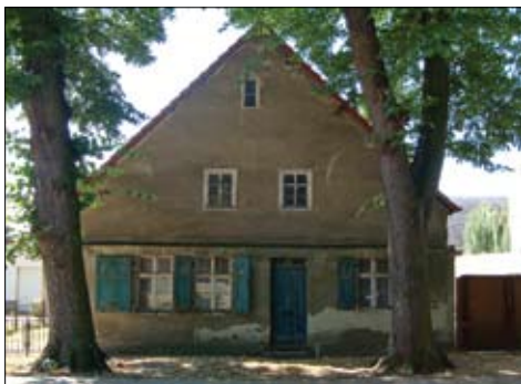
Abbildung 15: Ortstypisches, leerstehendes Gebäude, Schlalach
