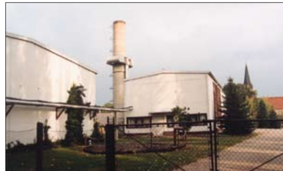
Abbildung 12: Ehemaliges Heizwerk, Trebatsch
