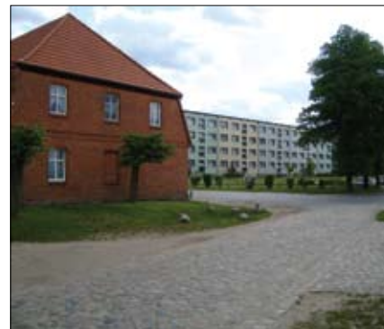
Abbildung 6: Teilweise leerstehender Geschossbau am Ortsrand, Milmersdorf
