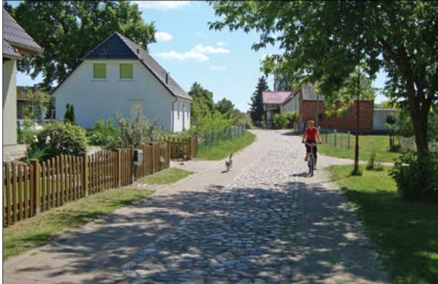
Abbildung 57: "Am Anger" mit neuen Wohngebäuden
