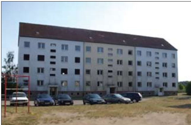
Abbildung 54: Wohngebäude vor dem Abriss
