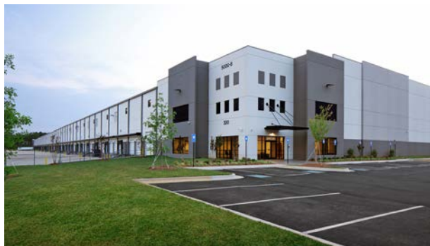
Abbildung 5: Struktur- und artenarme Parkplatz-Eingrünung
