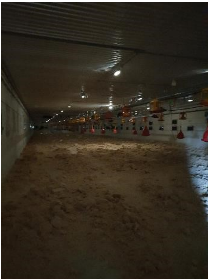
Abbildung 55: Heller Lichtkegel durch falsche LED-Ansteuerung bei der Dimmung (© StanGe, Hochschule Osnabrück)
