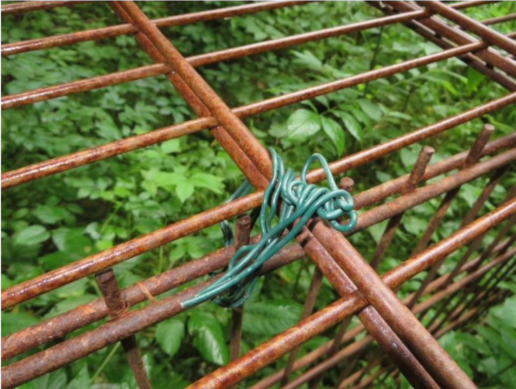
Abbildung 27: Alle Teile des Bausatzes werden mittels Draht verbunden (Foto: Dr. Egbert Gleich)
