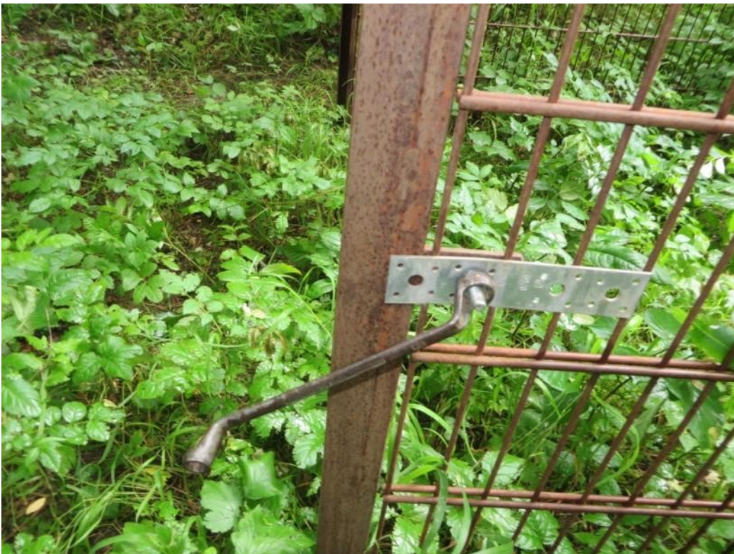
Abbildung 28: Lediglich der Fangtorrahmen wird mit den Seitenteilen verschraubt (Foto: Dr. Egbert Gleich)
