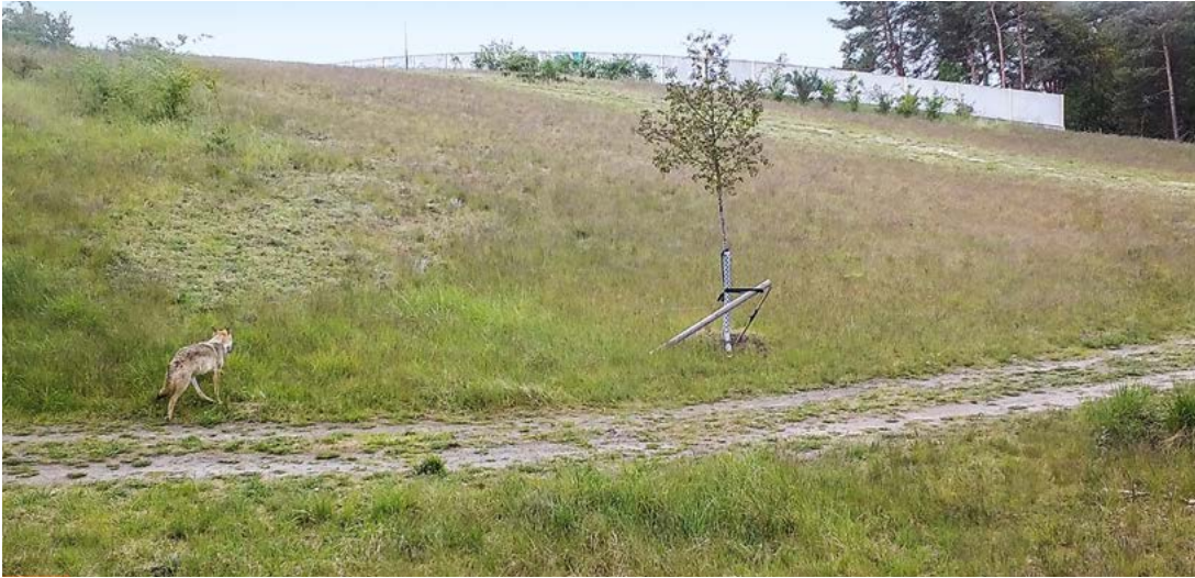
Wolf in einer Fotofalle an der Grünbrücke A101 bei Luckenwalde Süd. Die Grünbrücke überspannt hier die Straße und die Bahnlinie.
