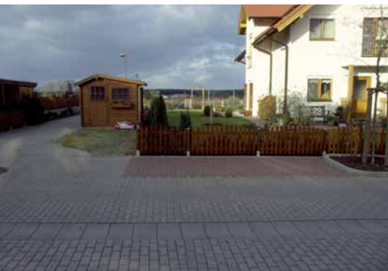
Abb. 102: Das neue Wohngebiet in Ladeburg (Barnim) in der Nähe eines Rotbauchunken-vorkommens wurde mit Flachborden ausgestattet. Foto: Norbert Schneeweiß
