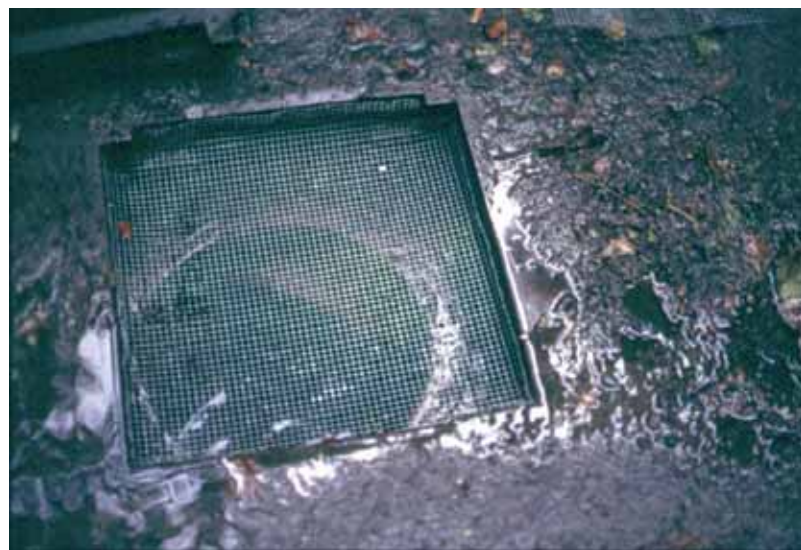
Abb. 101: Ein Schutzgitter unter dem Deckel entschärft die Fallenwirkung eines Gullys. Foto: Brigitte Bender.
