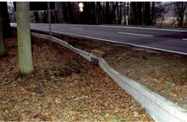
Abb. 94: Funktionsfähige stationäre Amphibienschutzanlage an der B 198. Foto: Norbert Schneeweiß
