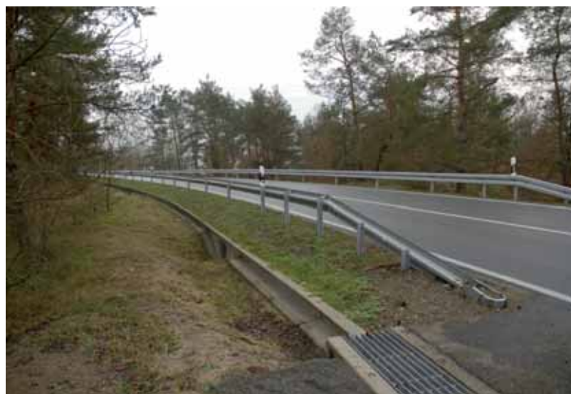
Abb. 76: Laubfroschsichere Amphibienbarriere entlang der Straße am Ponnsdorfer Kiesschacht (Elbe/Elster). Foto: Norbert Schneeweiß
