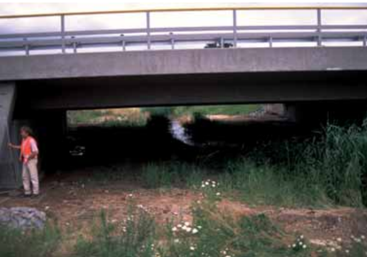
Abb. 98: Überbrückung eines Wilddurchlasses an der A-20 (Uckermark). Dieser Durchlass wird auch von Amphibien genutzt. Foto: Norbert Schneeweiß
